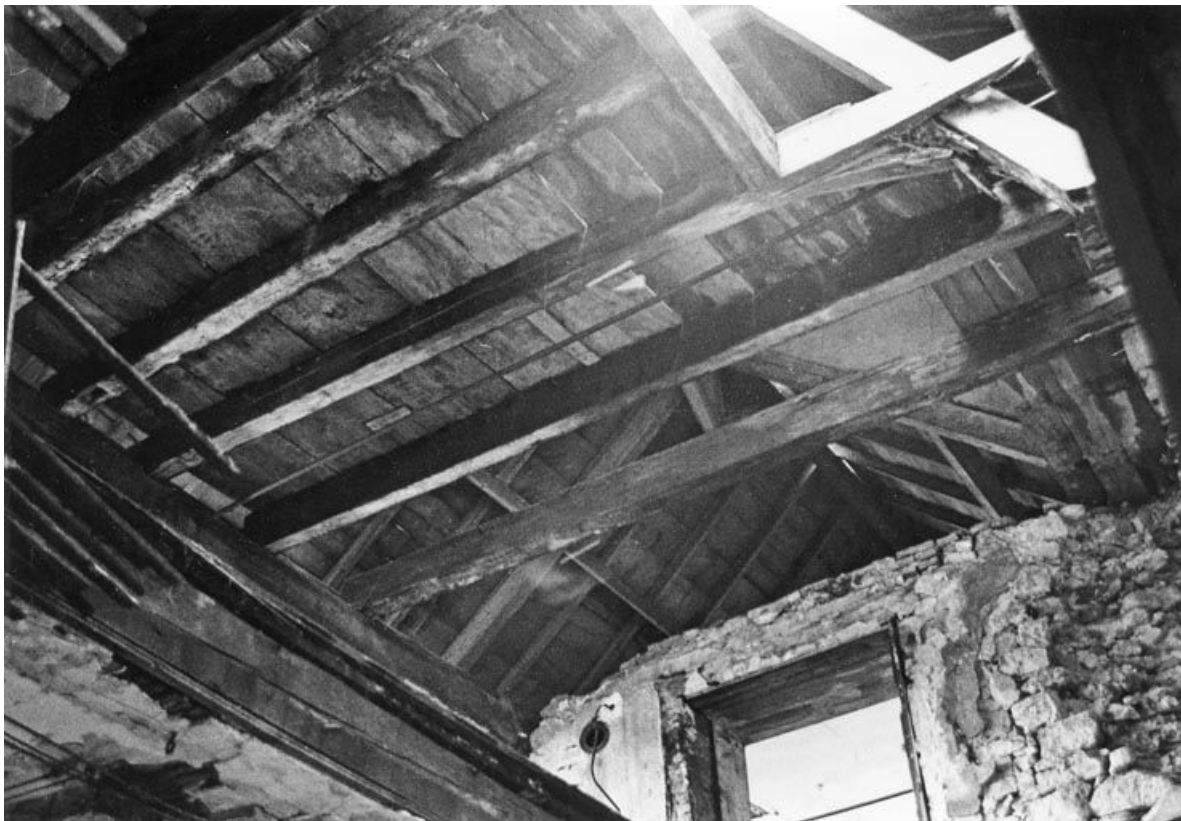
Atelier de fabrication : détail de la charpente.
