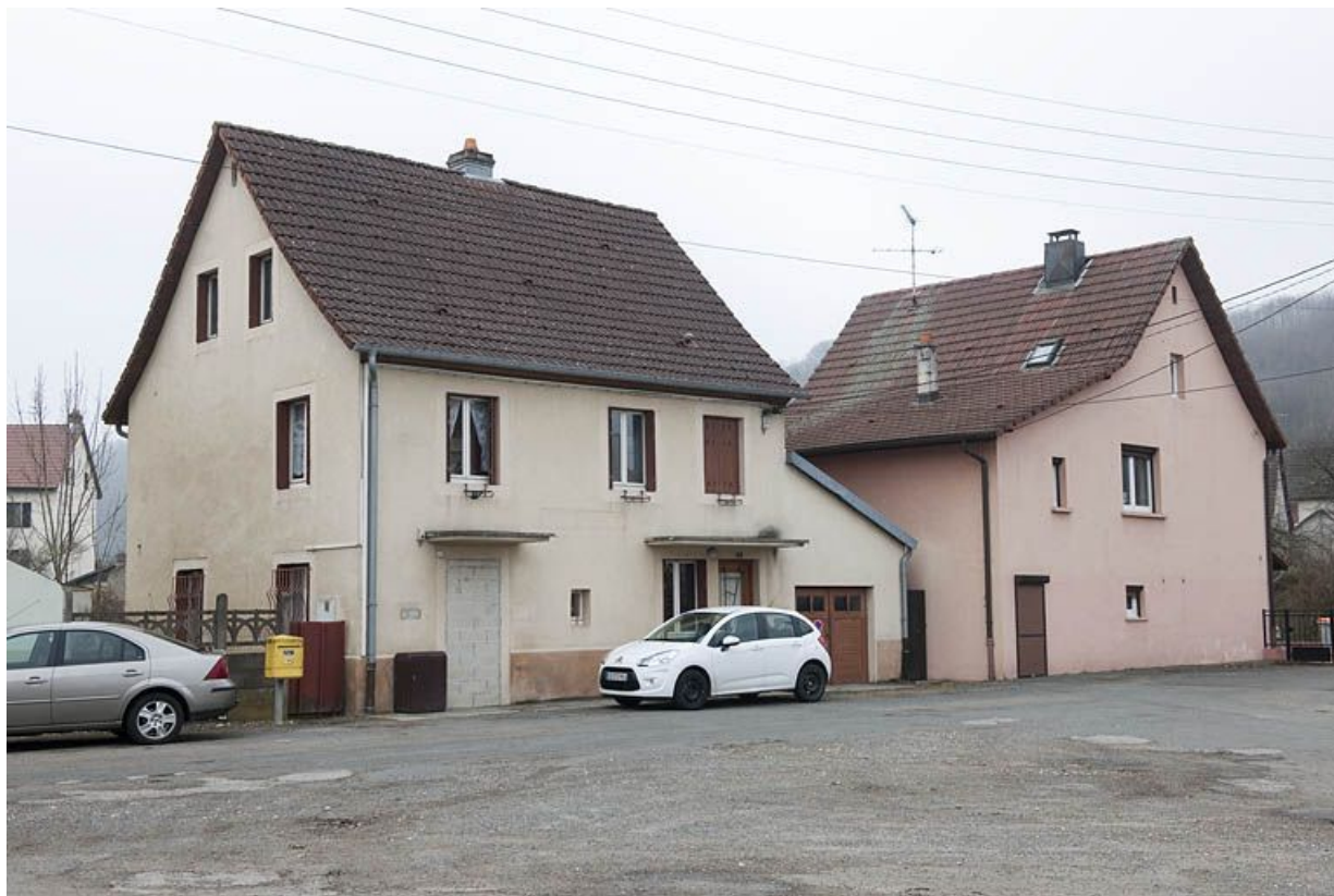
Maisons individuelles rue de la Poste.
