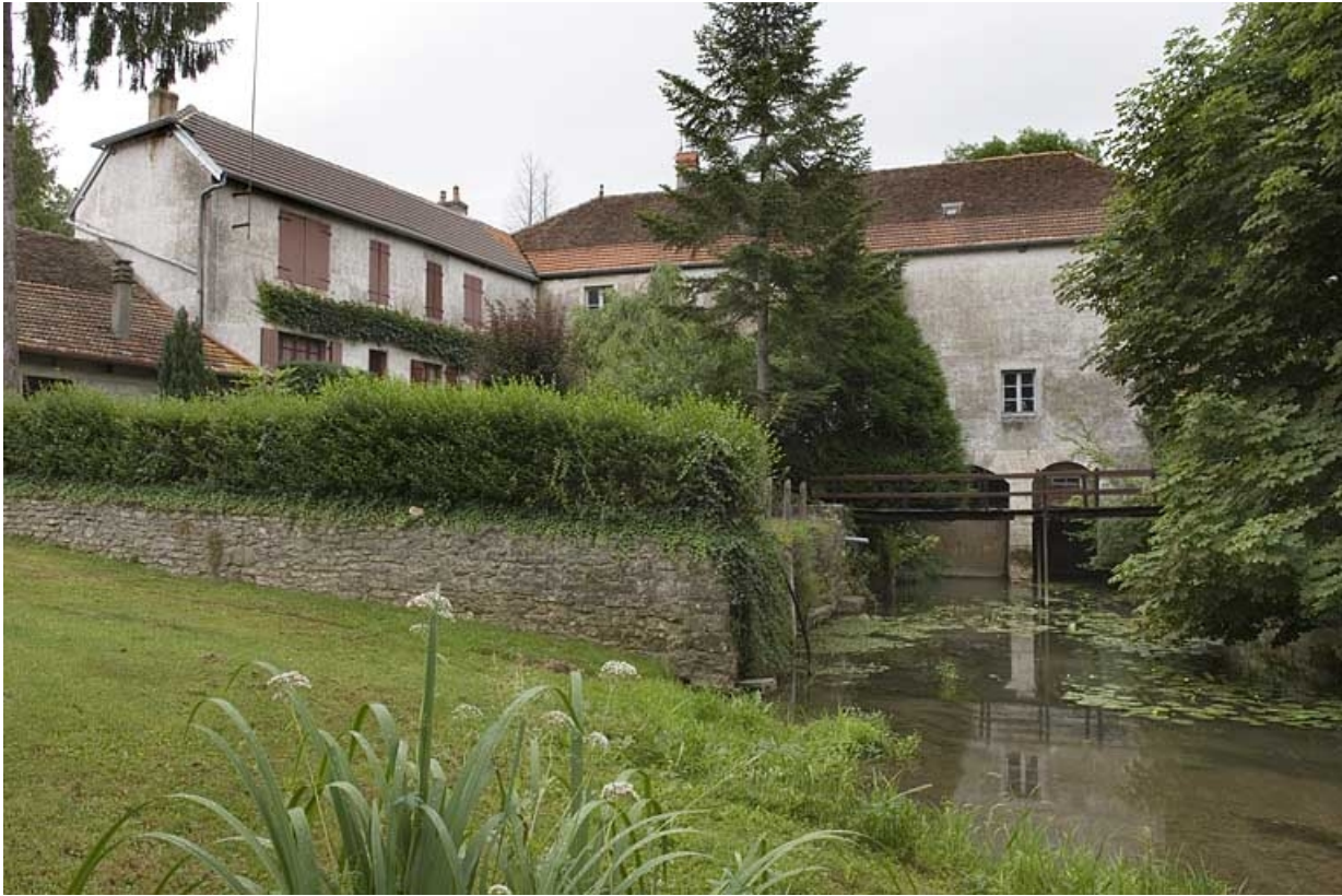
Vue d'ensemble depuis le bief, en aval.
