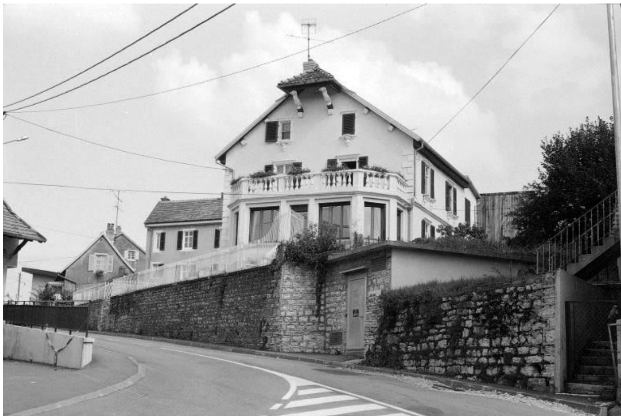
Façades latérale droite et postérieure.
