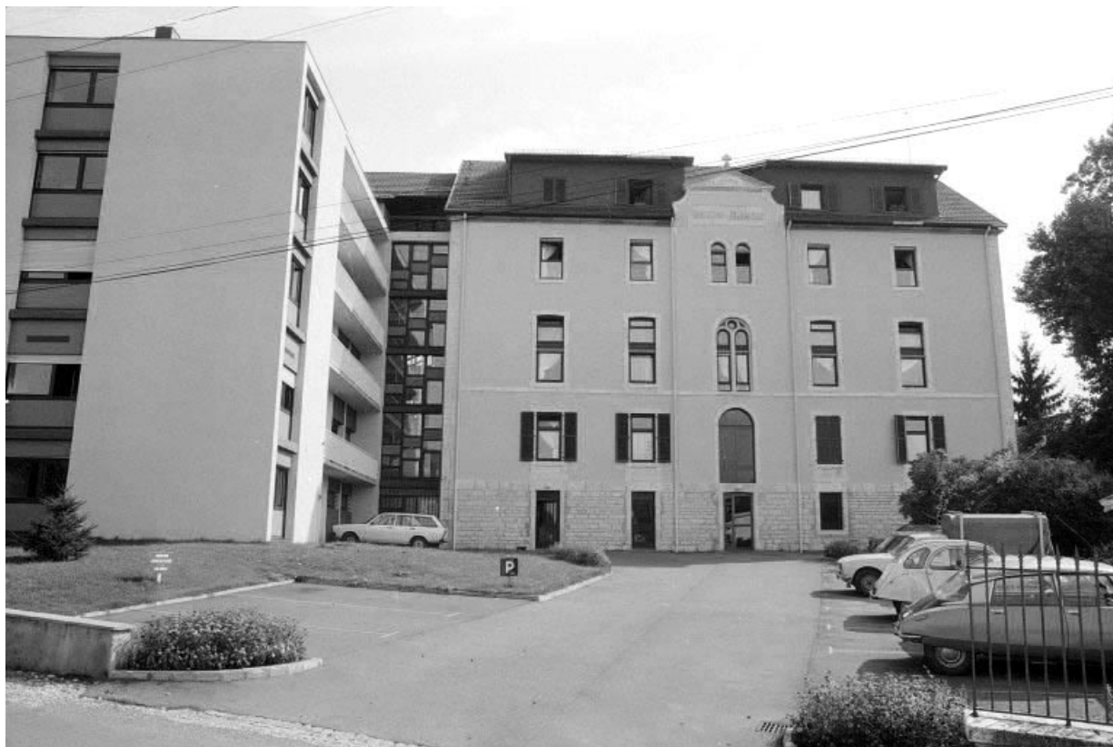
Façade antérieure et annexe.
