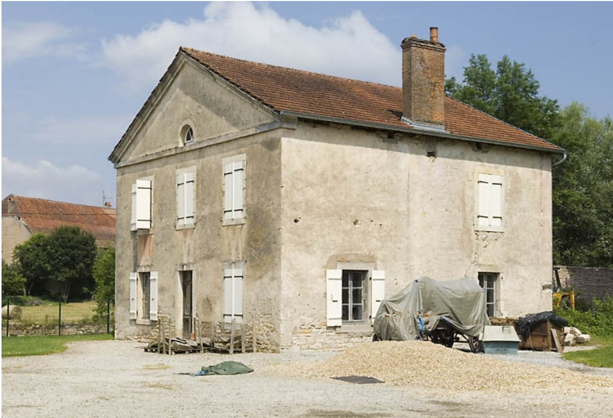
Logement patronal vu de trois quarts en 2008.
