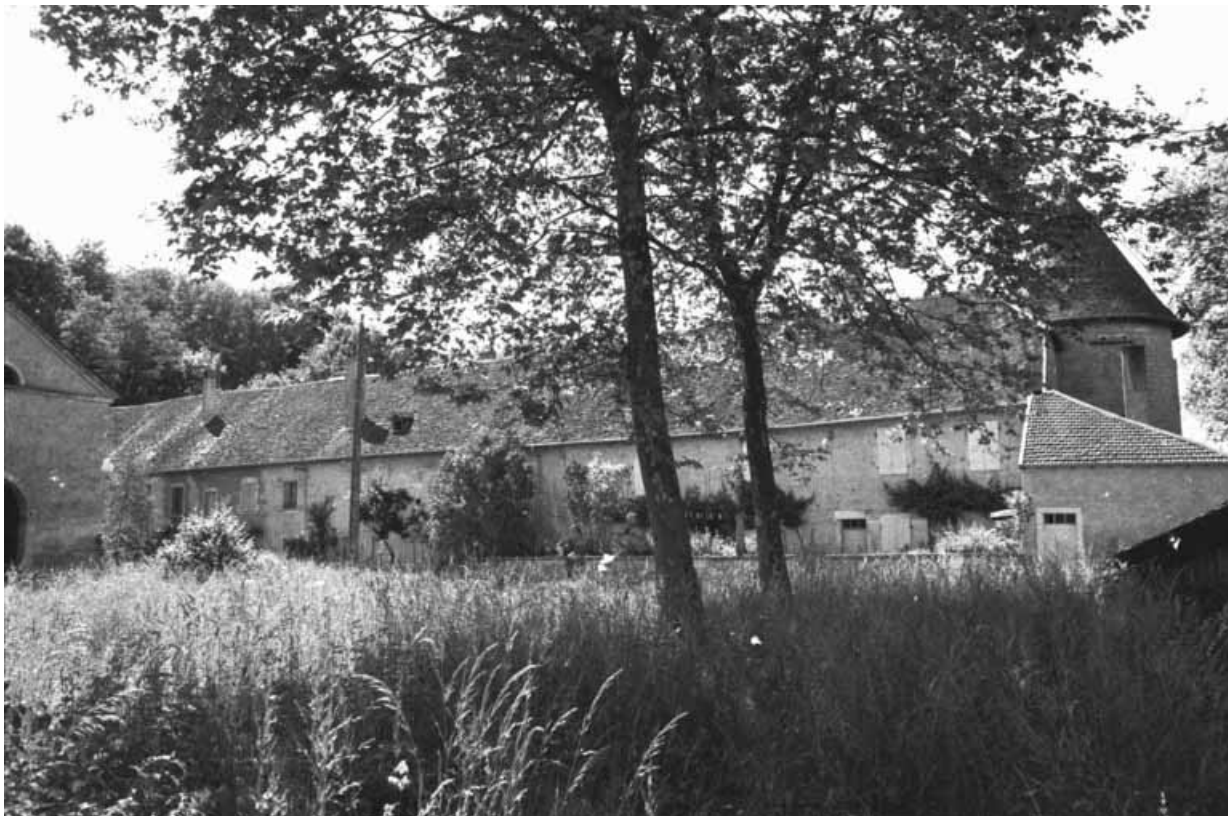
Vue d'ensemble du logement ouvrier en 1981.
