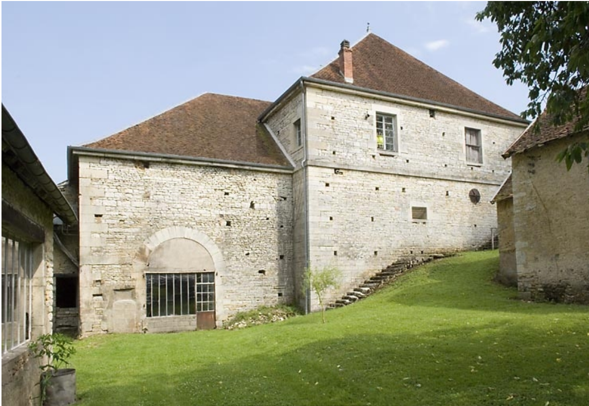
Le haut fourneau vu depuis l'ouest.
