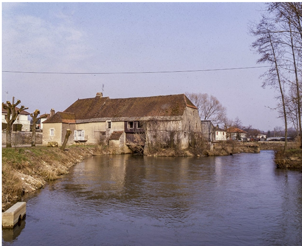
Vue d'ensemble depuis le pont.
