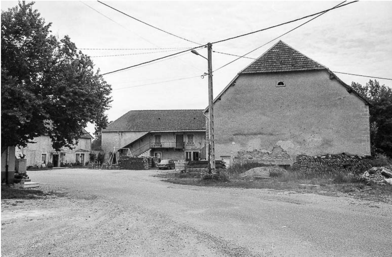
Vue d'ensemble des bâtiments en U.
