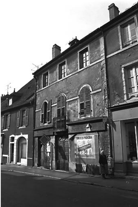
Façade antérieure avec magasins au rez-de-chaussée.
