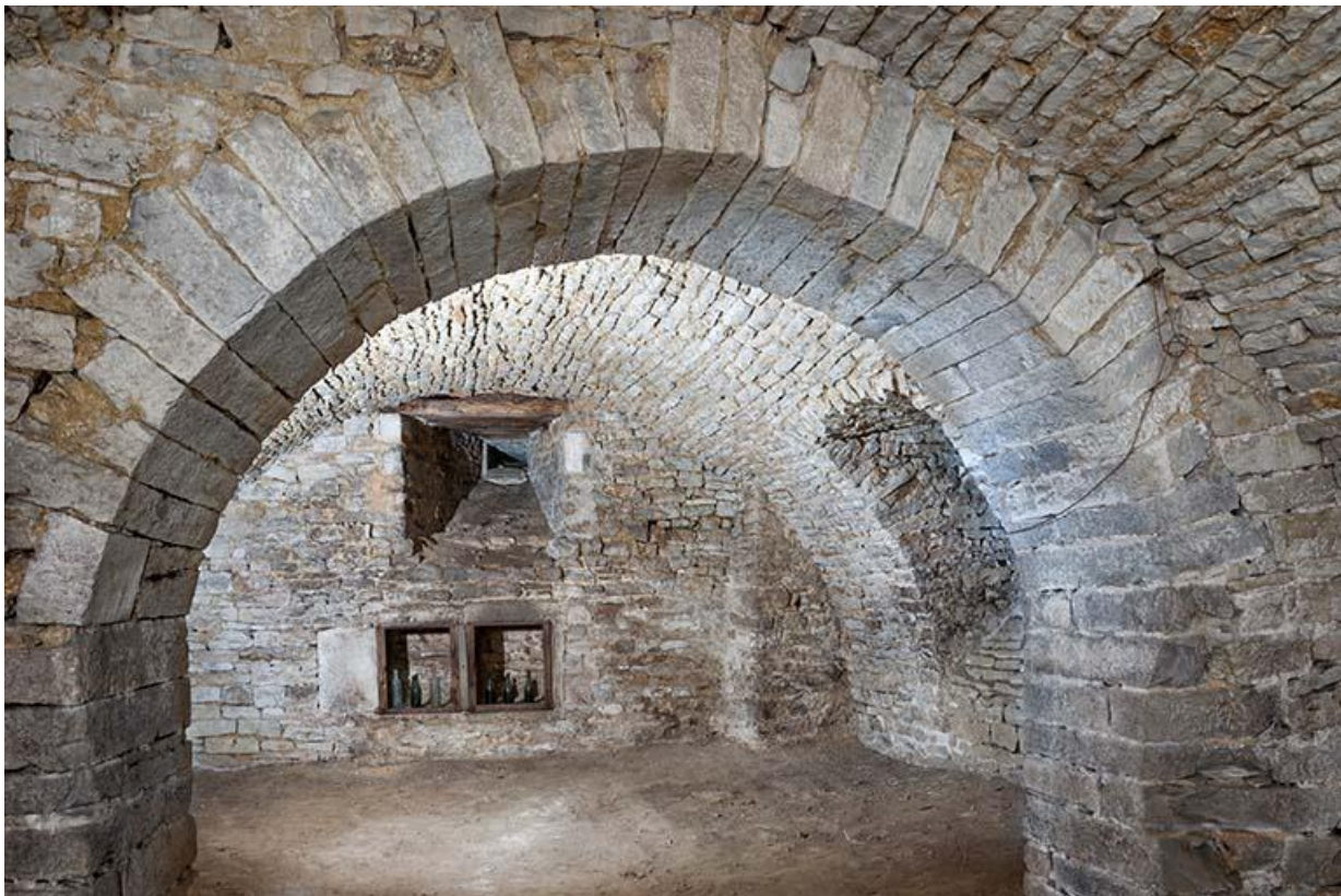
Vue générale de la cave
