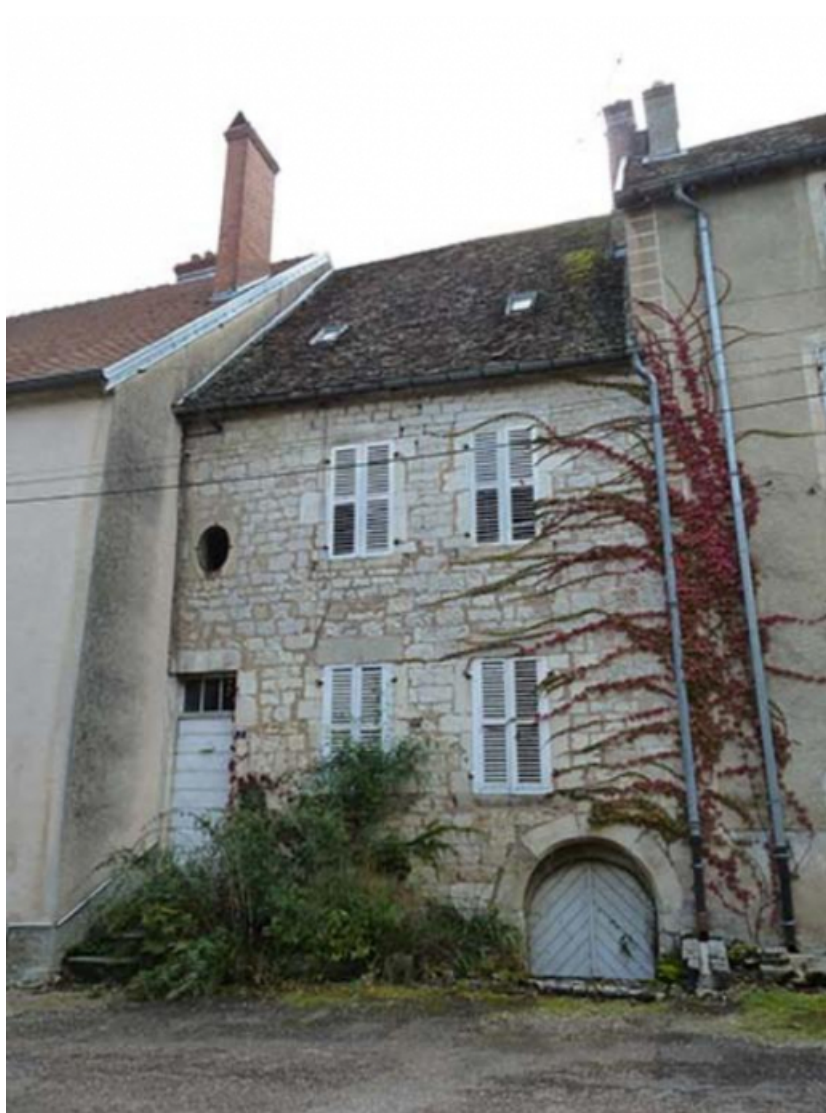
Vue générale nord-ouest
