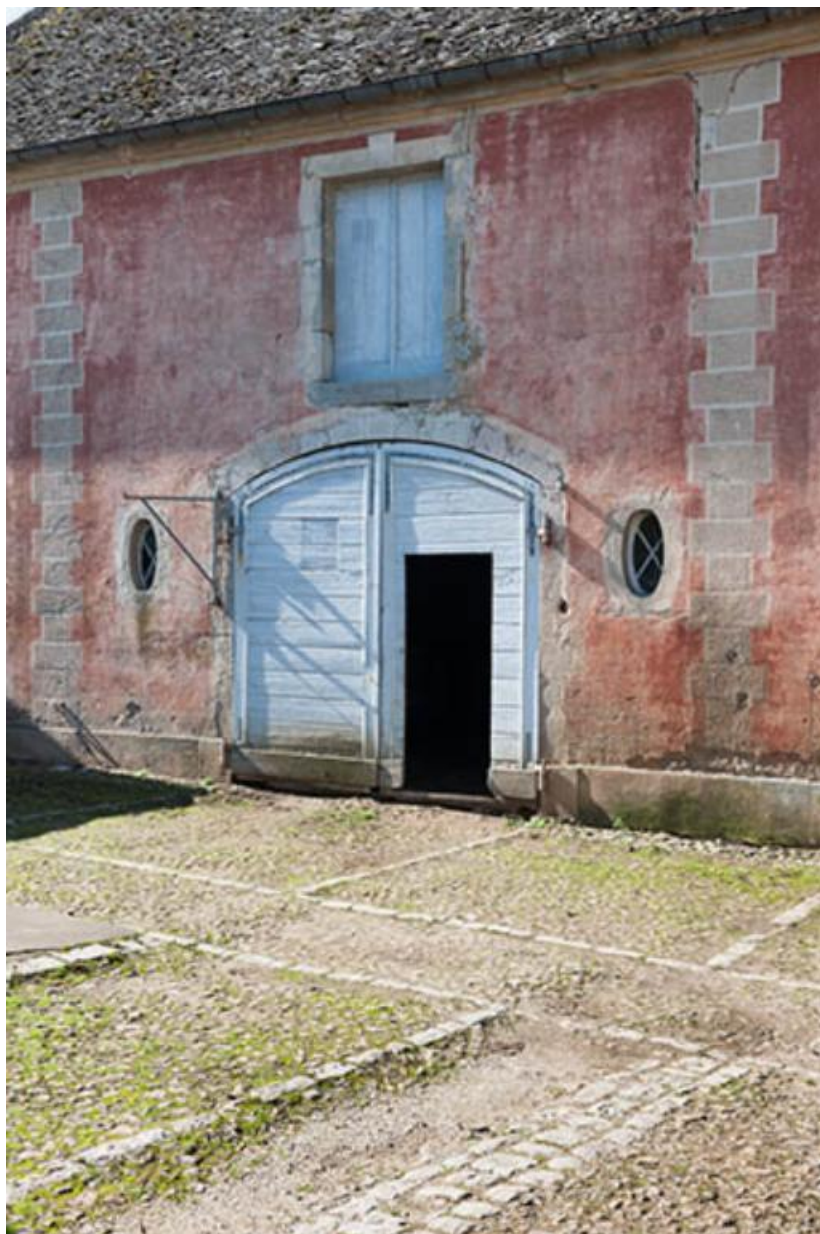
Détail du bâtiment de dépendances
