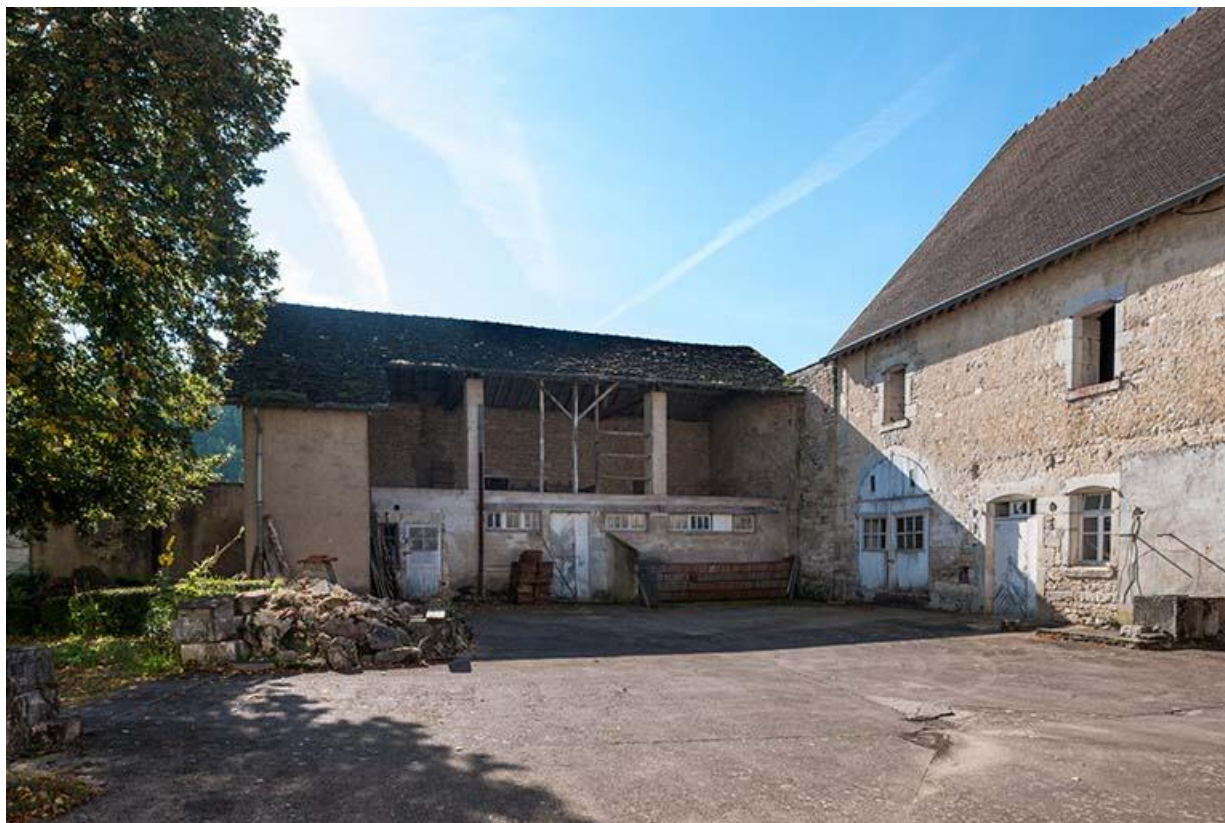
Dépendances situées au sud-ouest de la cour
