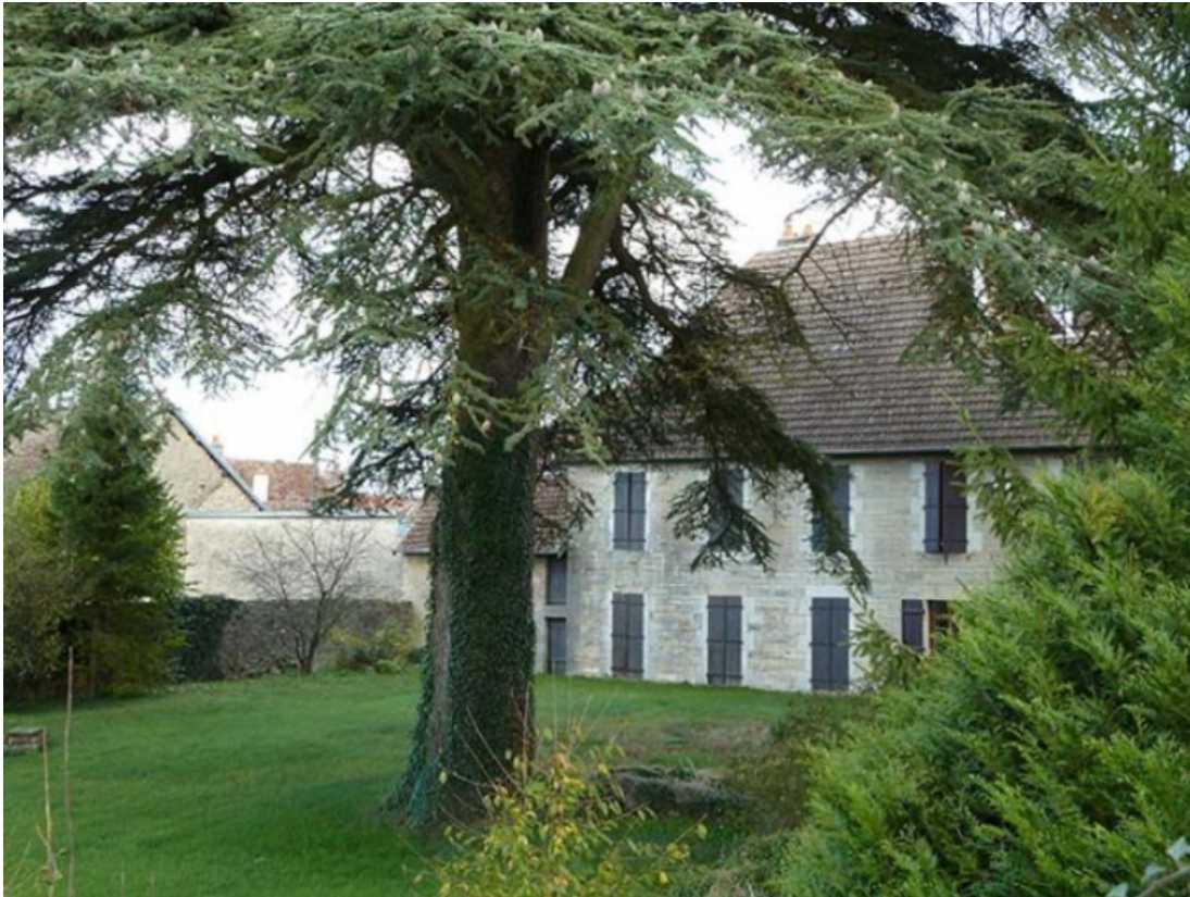
Façade postérieure (ouest)
