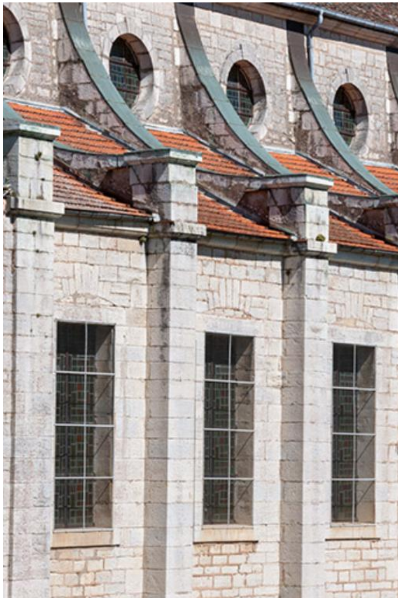
Détail de la façade sud
