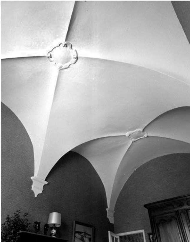
La voûte de la chapelle.
