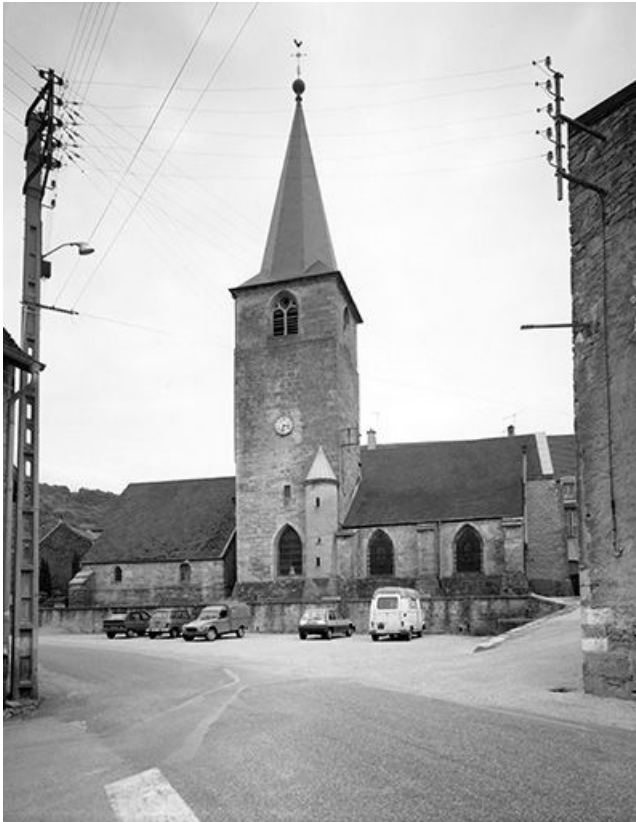
Façade latérale gauche.
