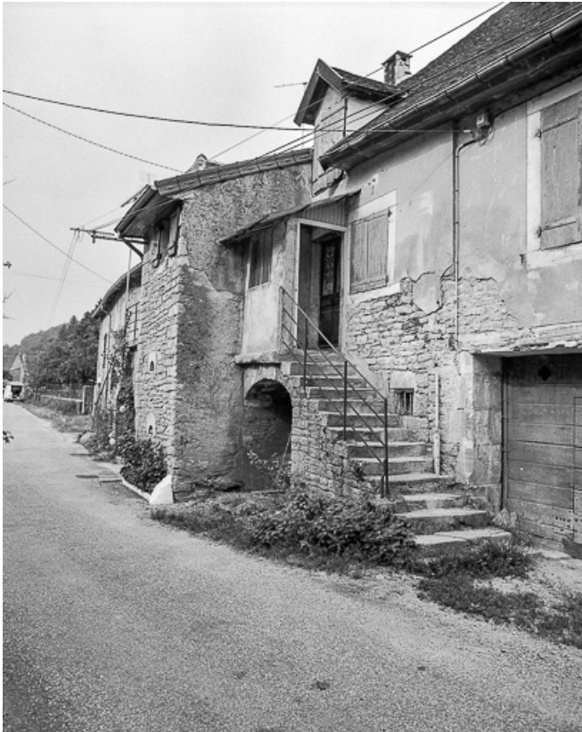
Façade antérieur : escalier à droite de l'avancée.
