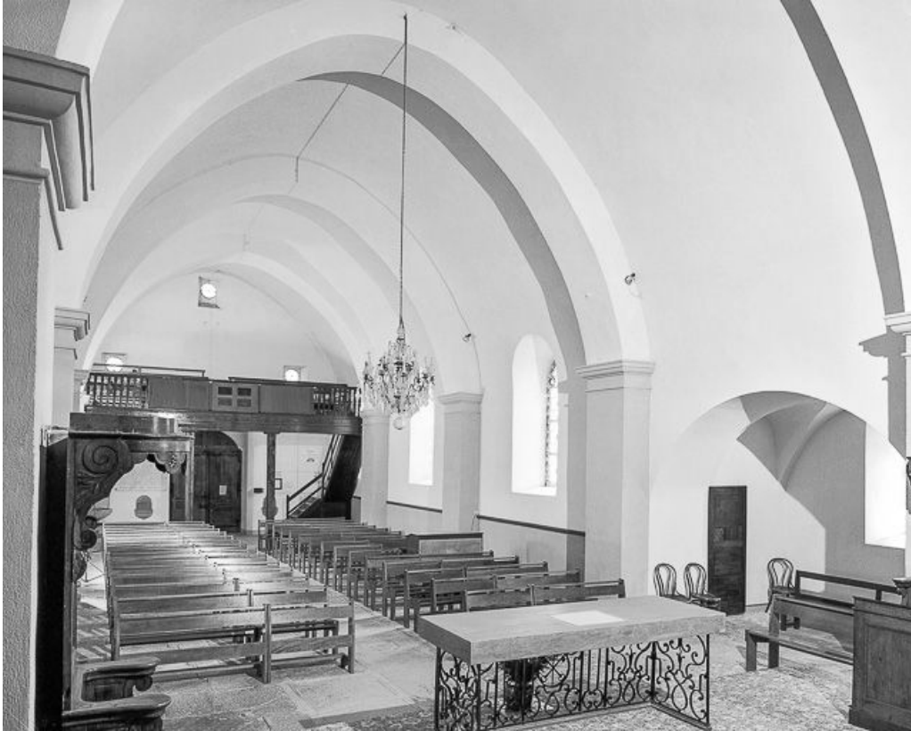
Nef vue depuis le chœur.
