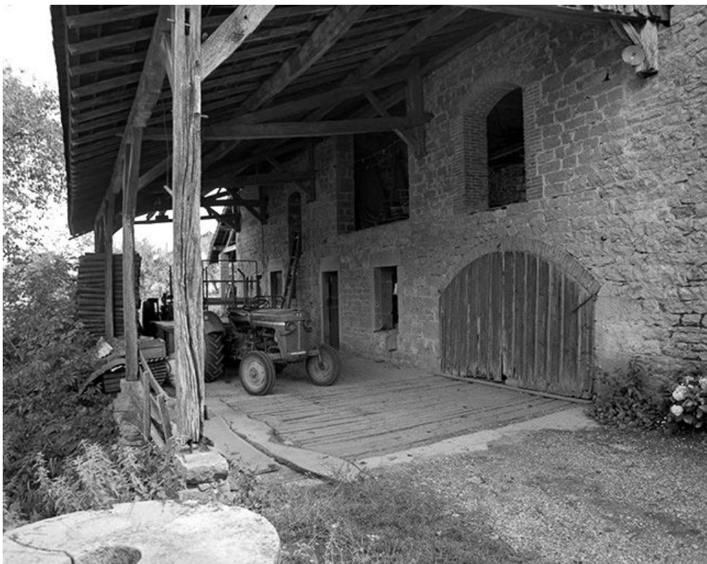
Façade antérieure, partie gauche.
