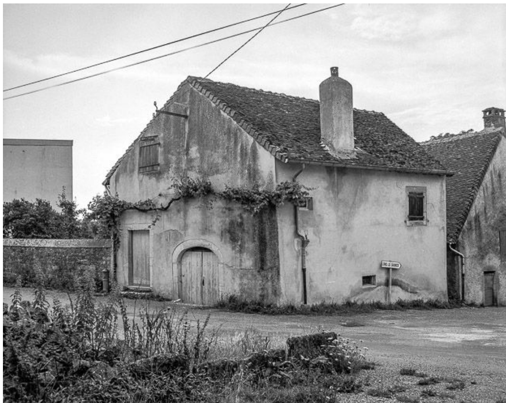
Façades antérieure et latérale droite.
