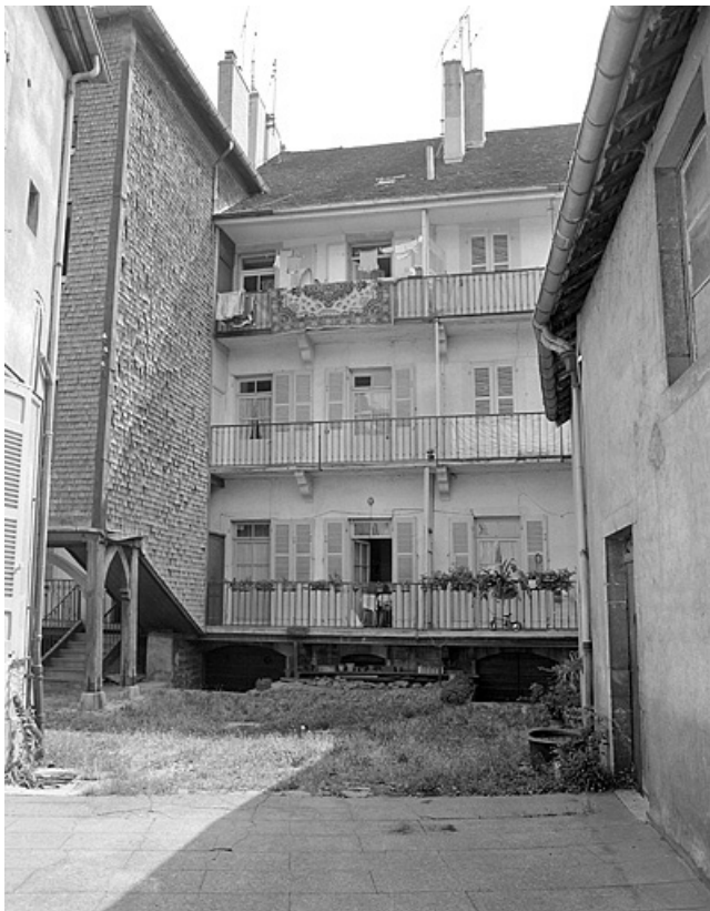
Façade postérieure montrant l'escalier à gauche.
