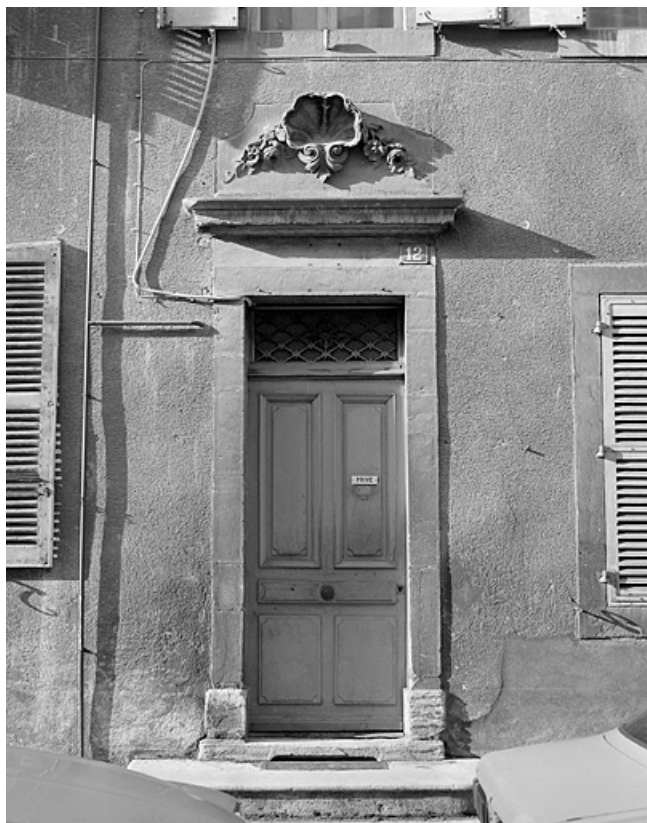
Façade antérieure, porte d'entrée.
