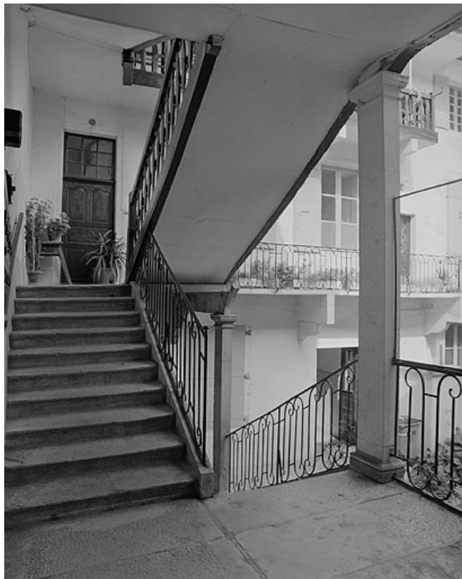
Escalier vu depuis le premier palier.
