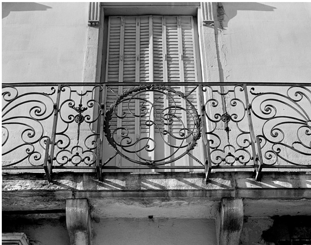
Façade antérieure, détail du balcon.
