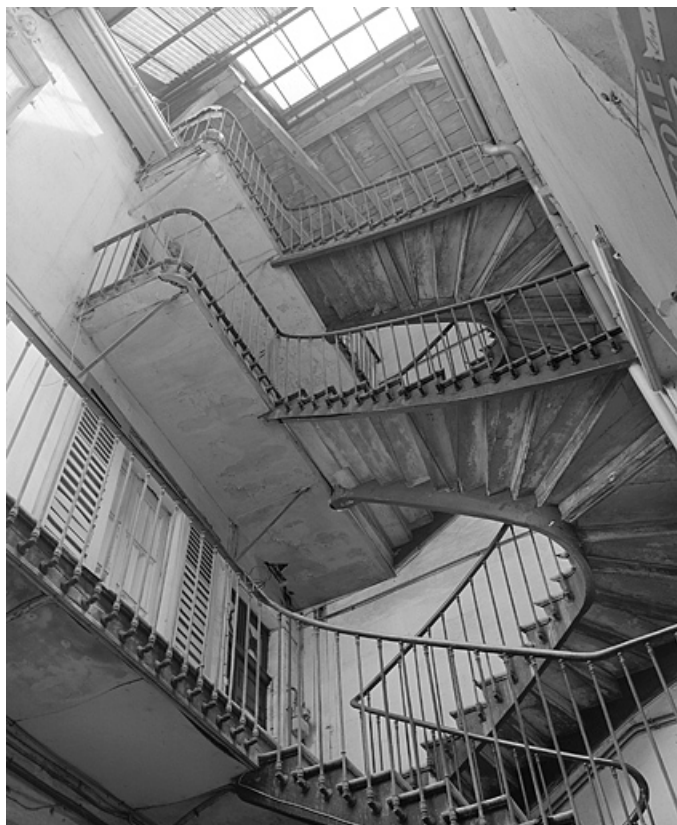
L'escalier, vue générale.
