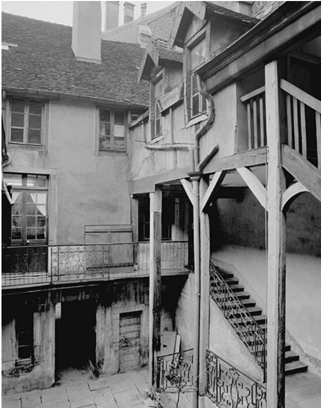
Vue de la cour intérieure avec l'escalier.
