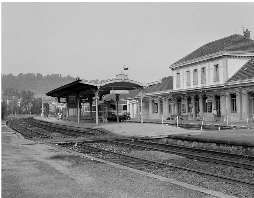
Façade postérieure et abri sur le quai.
