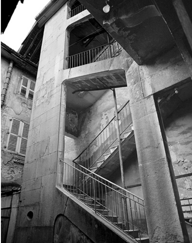
Maison, 16 rue Regard, escalier sur cour. 39, Lons-le-Saunier
