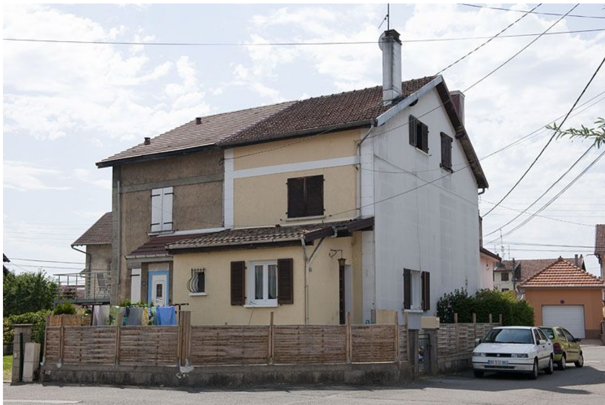
Habitation à 4 logements. Vue de trois quarts.
