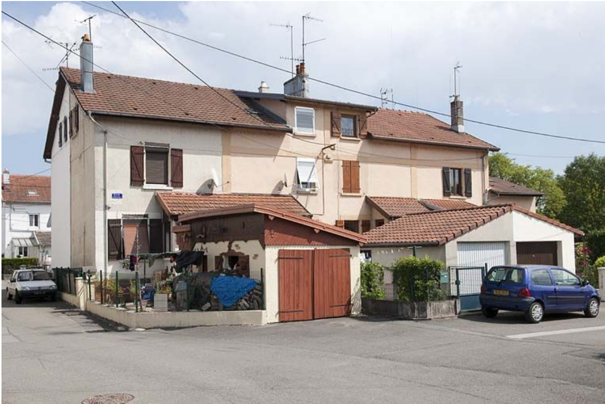
Habitation à 8 logements. Façade ouest.
