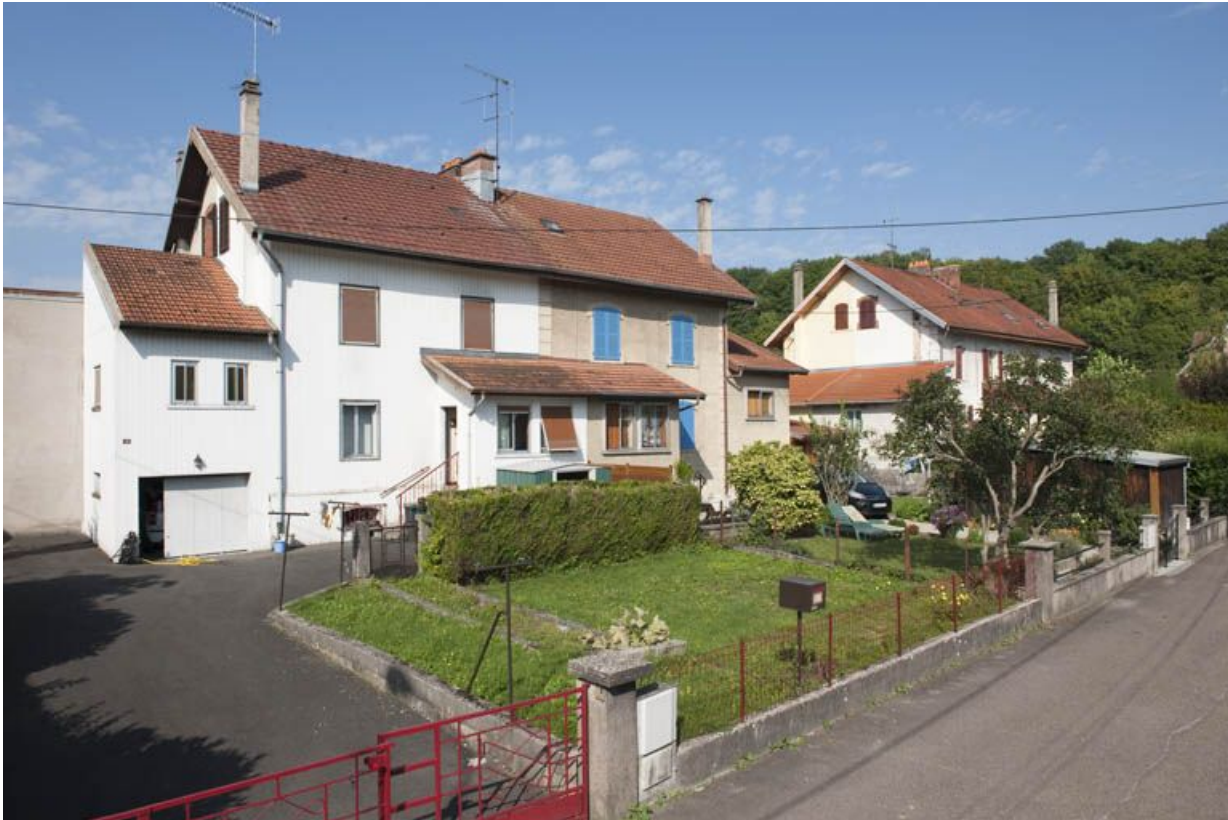
Habitations à 4 logements vues de trois quarts.
