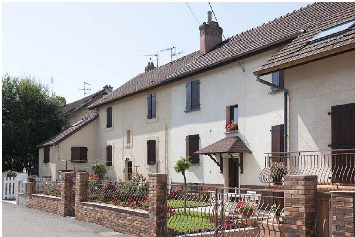
Habitation vue de trois quarts droite.
