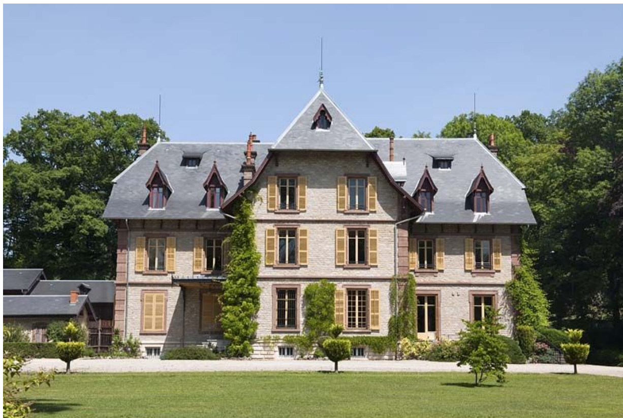
Vue rapprochée de la façade antérieure.
