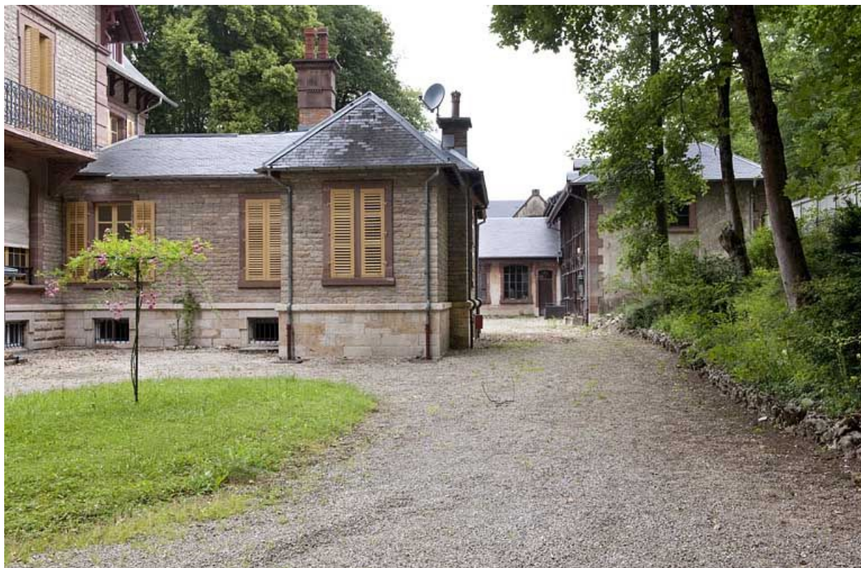
Façade sud de l'annexe et communs.
