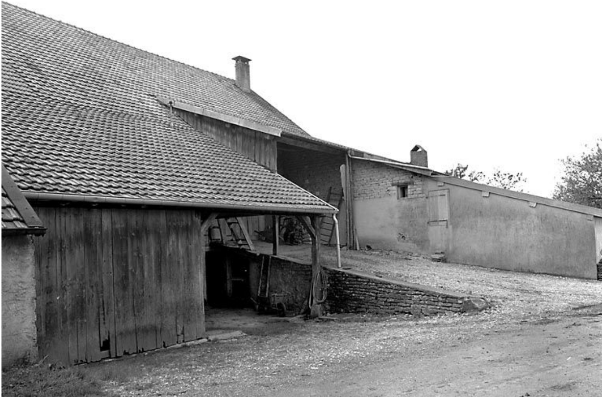
Façade latérale gauche : le pont de grange.
