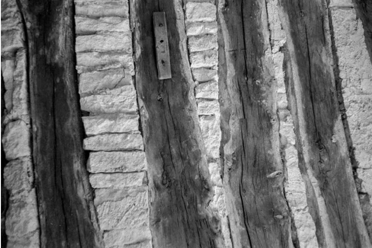
Intérieur des parties agricoles : le plafond.
