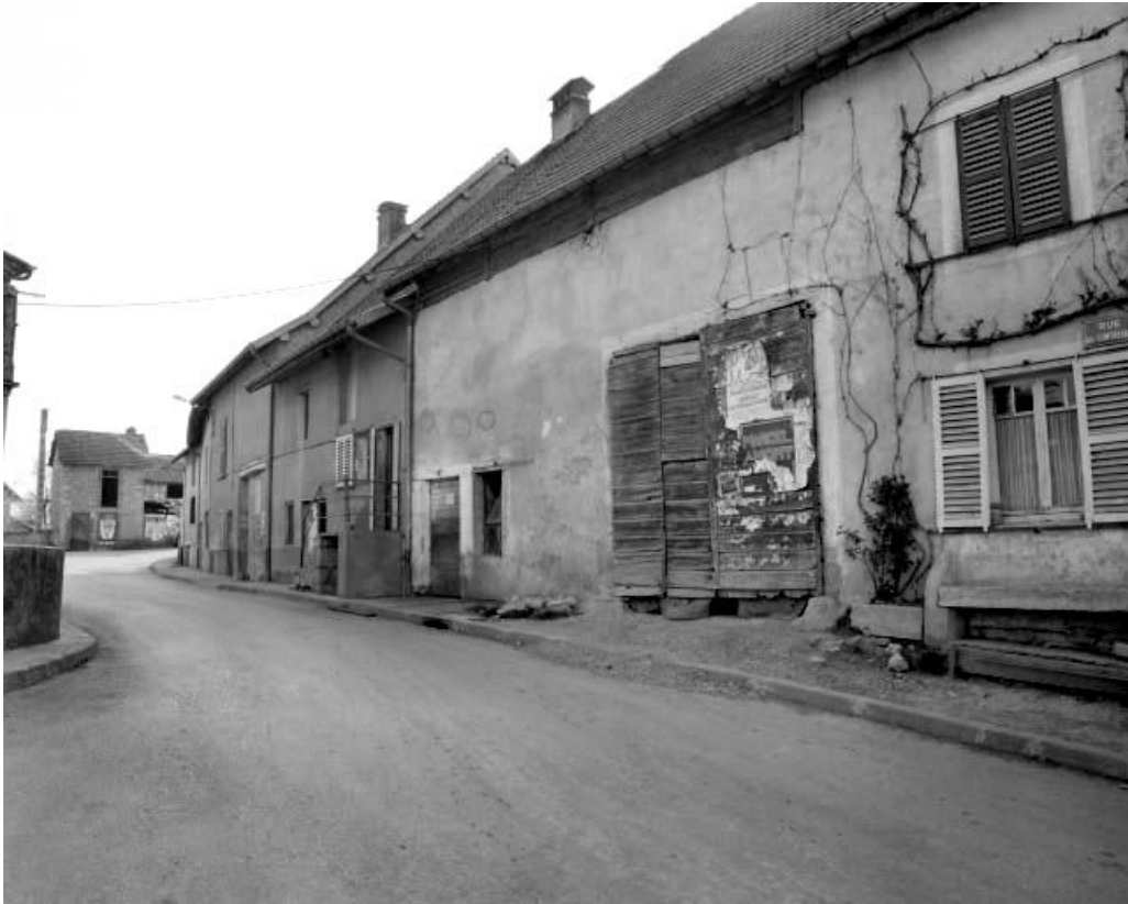
Ferme située 2 rue des Contrevaux.
