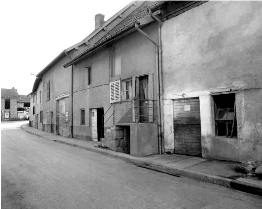
Maison de vigneron située 4 rue des Contrevaux.
