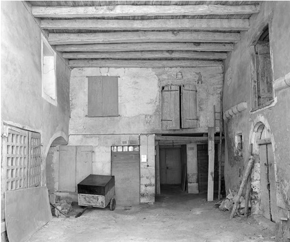
Façade antérieure : le passage plafonné.
