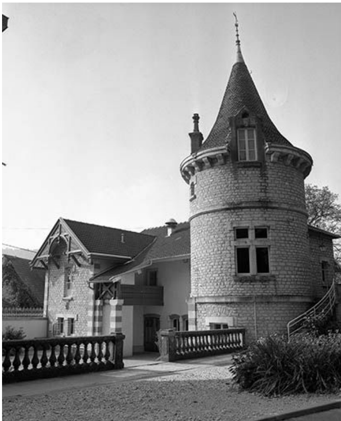
Façade antérieure des communs.
