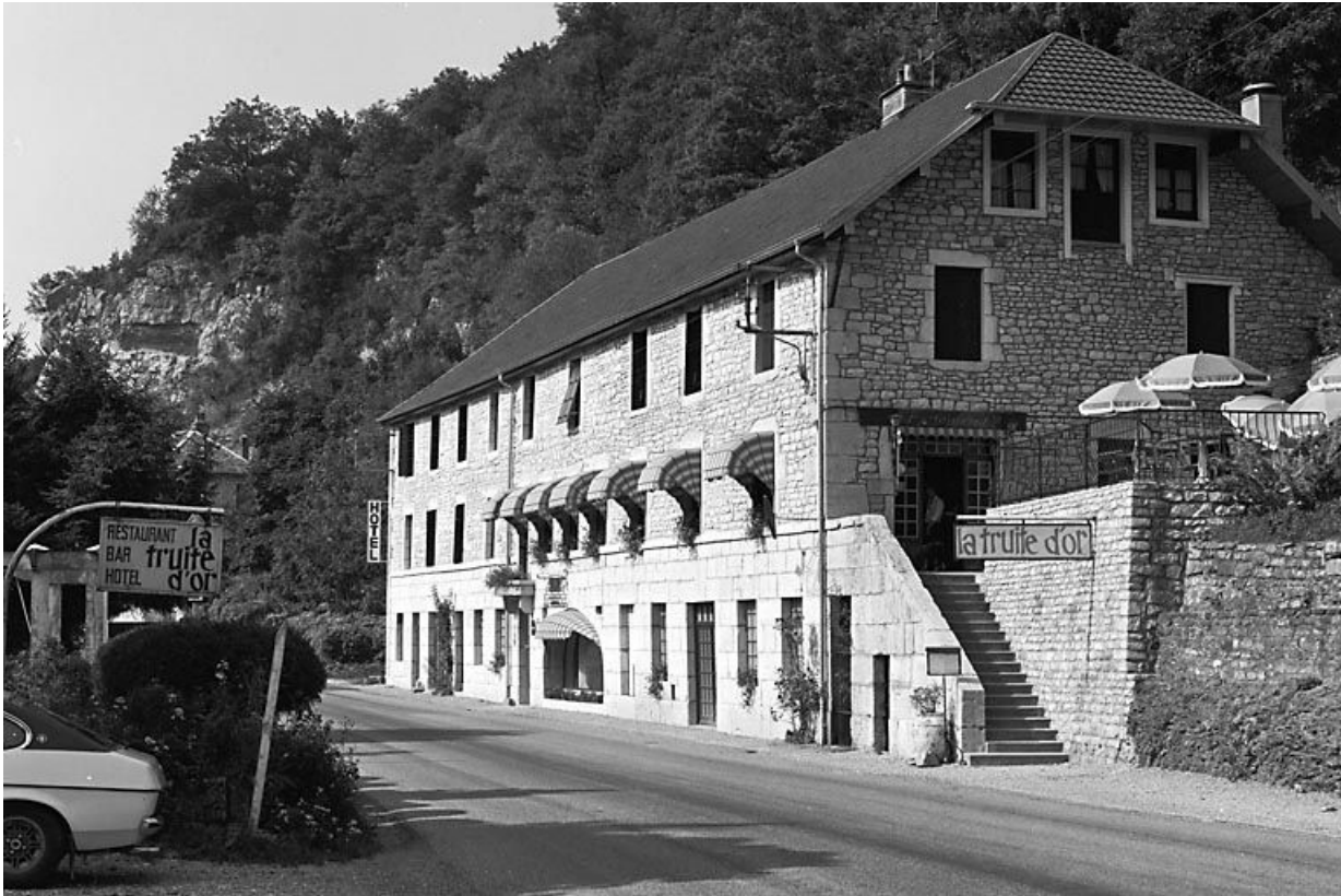
Façade antérieure de trois quarts droit. 25, Lods
