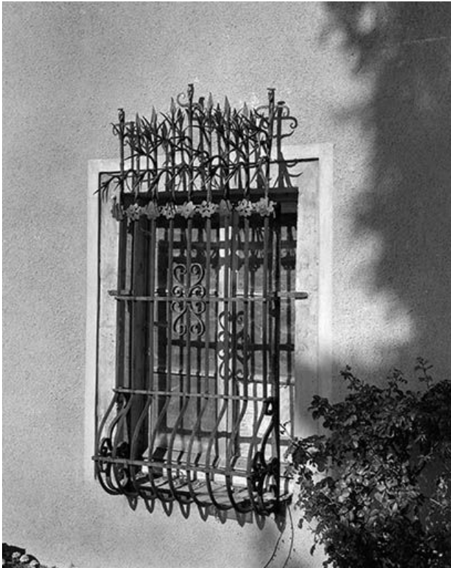
Une des baies du rez-de-chaussée des communs.
