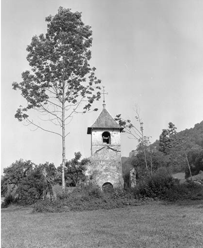
Tour du clocher depuis l'est.
