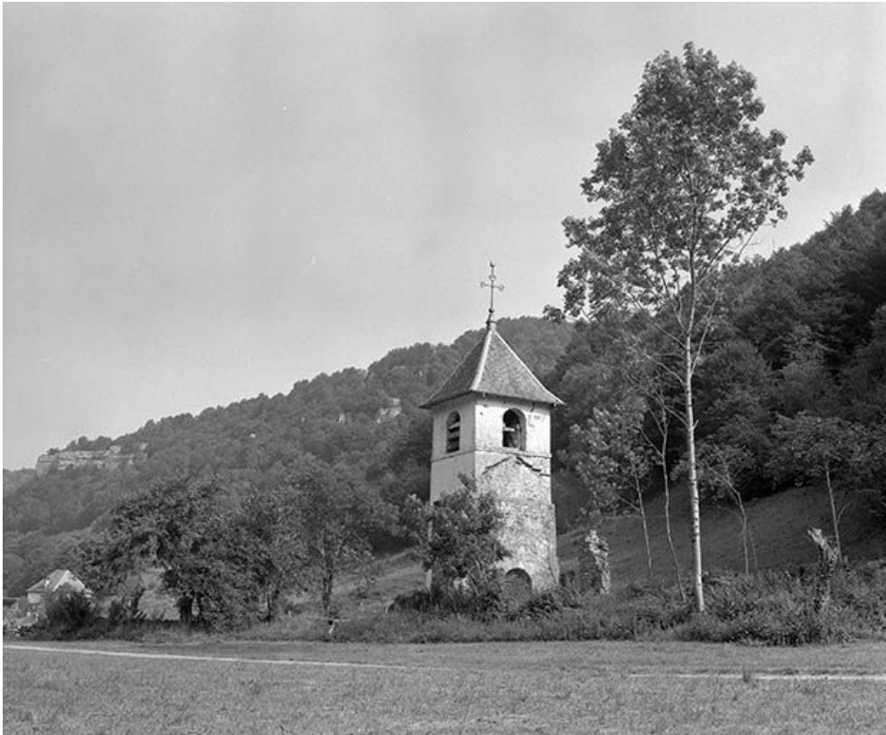
Tour du clocher depuis le sud-est.
