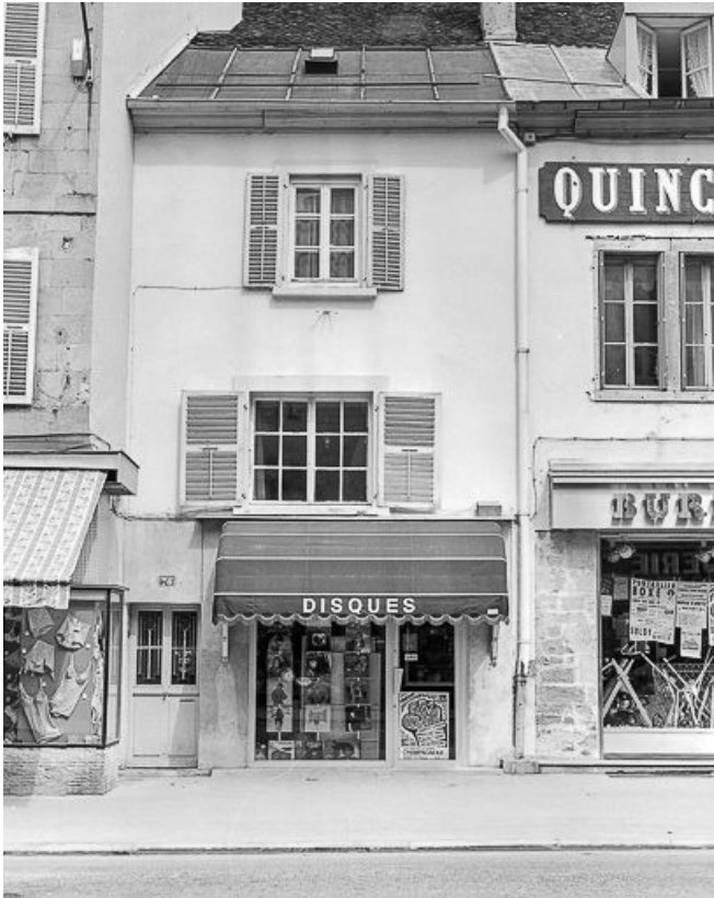
Façade sur rue, vue de face.
