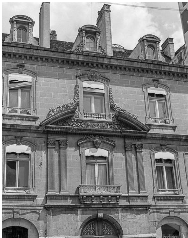
Détail du corps central.
