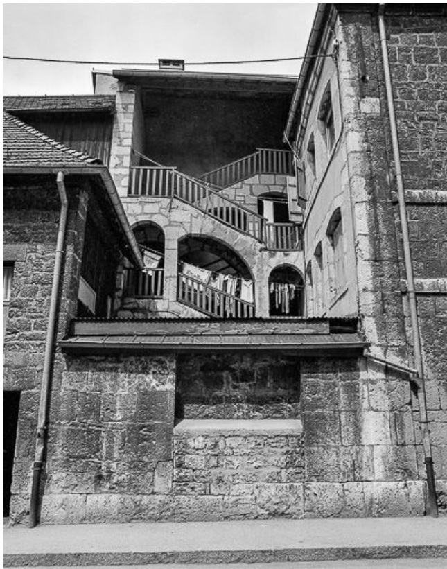
Escalier sur cour.
