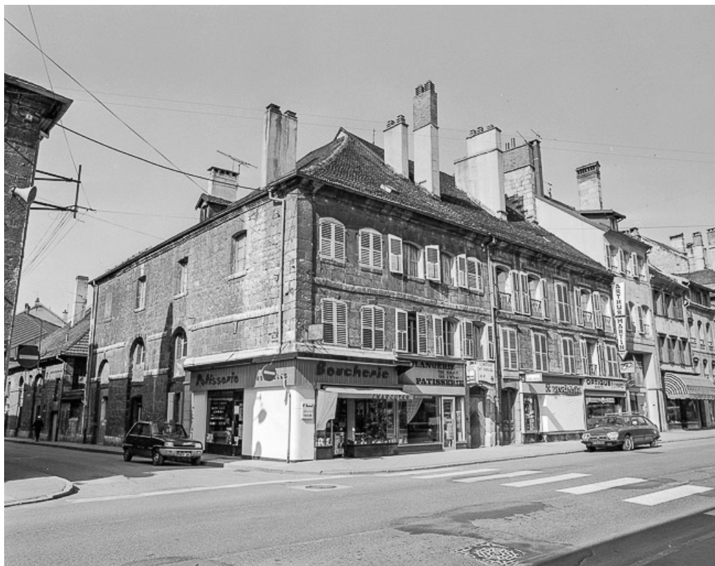
Façades sur rue.
