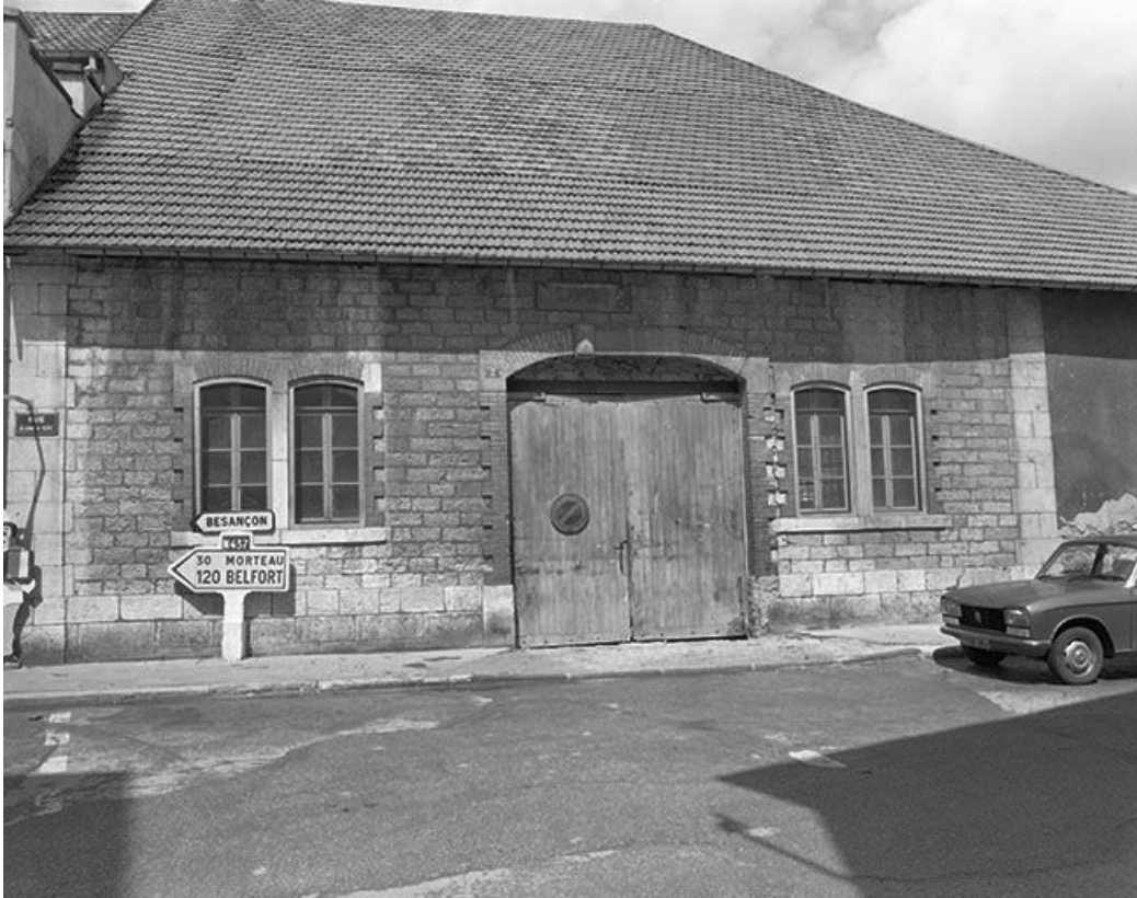
Façade sur rue, vue de face.
