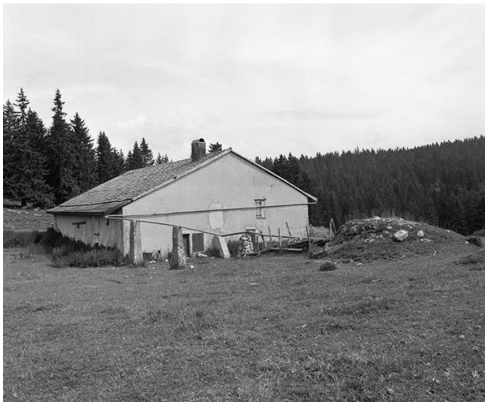
Façades postérieure et latérale gauche.
