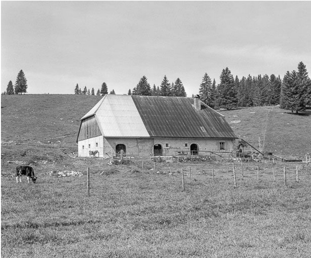
Pignon postérieur et goutterot gauche.
