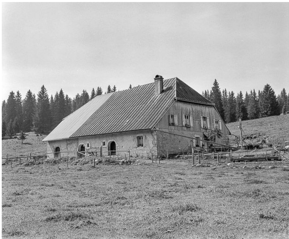
Façade antérieure et latérale gauche.
