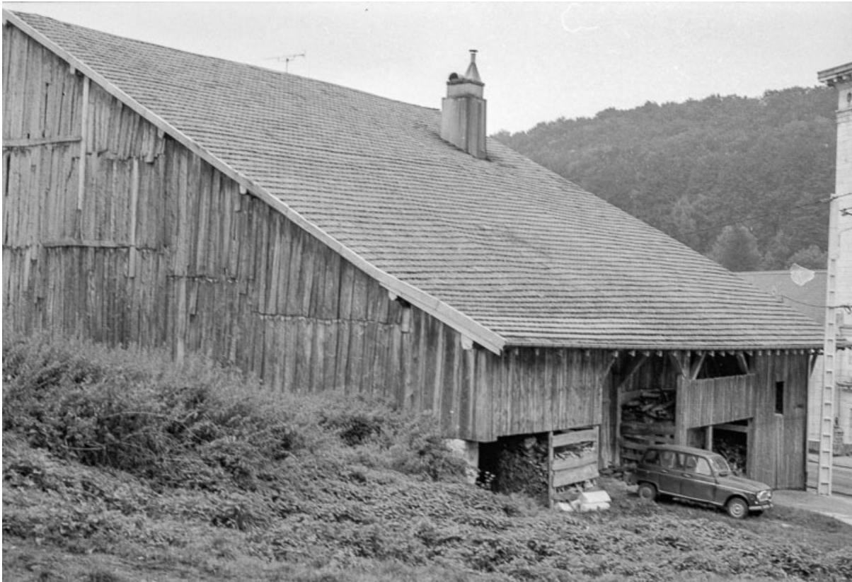
Façades postérieure et latérale gauche.
