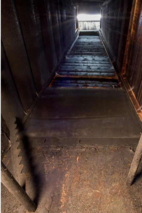
Grand tué : supports des perches et conduit.
