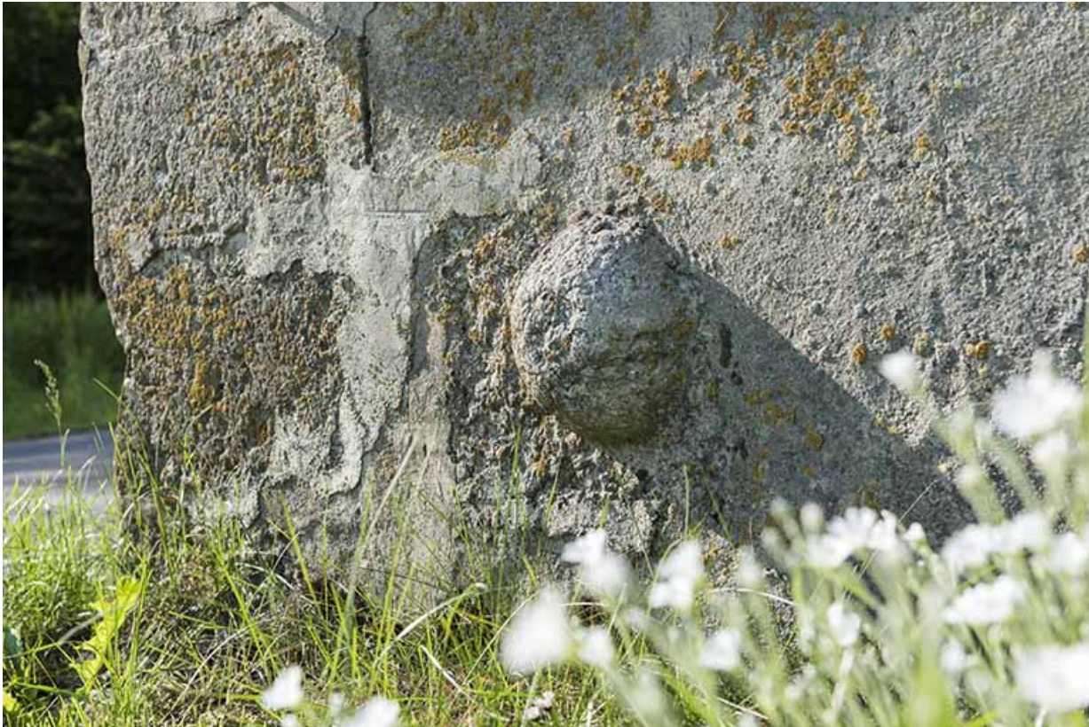
Façade nord : pierre avec relief hémisphérique.
